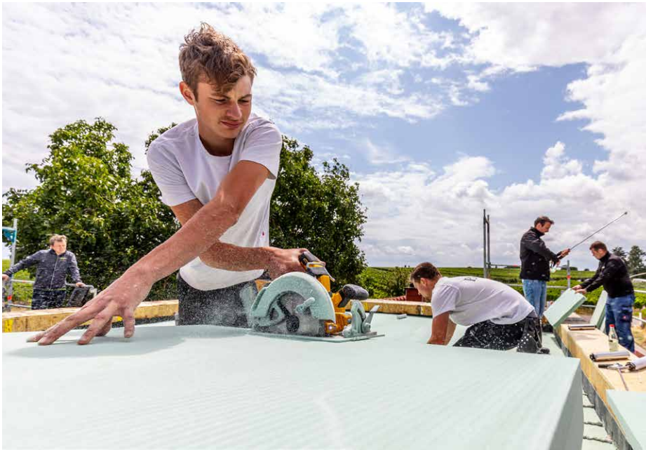
Einfache und staubarme Anpassungsarbeiten
