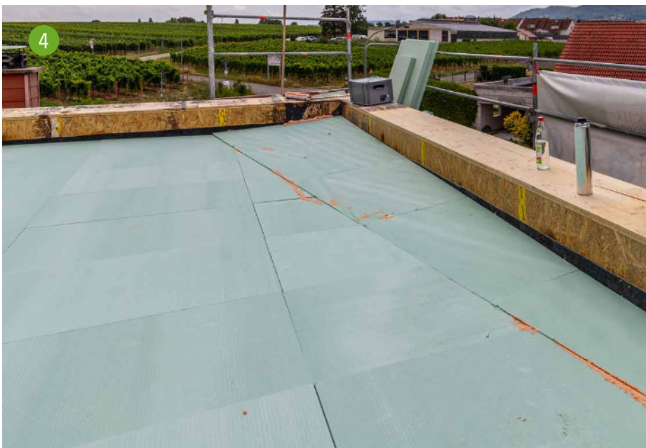
4/ Aufbringen der Gratplatten und weiterer Sonderbauteile
