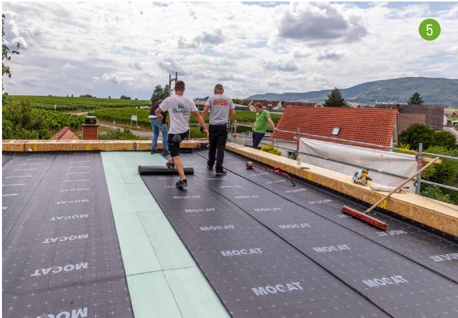
5 / Aufbringen der Dachabdichtungsbahnen nach Vorgabe des Herstellers
