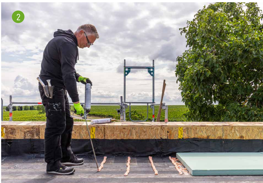
2 / Grunddämmung Vollflächige, ein- oder mehrlagige Dämmung mit PETtherm 50 Flachplatten
