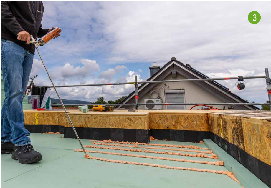
3 / Gefälledämmung mit PETtherm 50 Gefälleplatten
