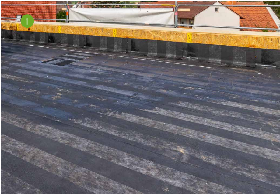
1 / Aufbringen der Dampfsperre
