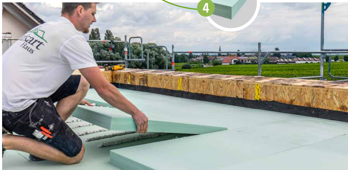
Flachdachdämmung mit Gefälleplatten für Wohnhausanbau mit Gründach
